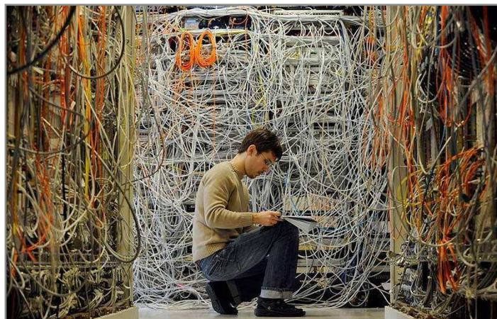
Figura 2 Um péssimo exemplo de cabeamento
