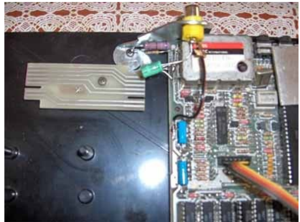
Imagen 5. Colocación del nuevo conector RCA
