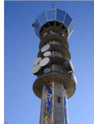
FIGURA 4: Torre emisora. La radiodifusión siempre se ha basado en buscar posiciones elevadas para el emisor. En países muy llanos hay que construir grandes torres (la contrapartida es que una torre sobre una llanura tiene un alcance enorme).
